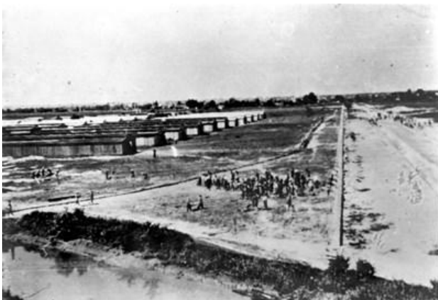
Birkenau, le baracche del campo in costruzione.
