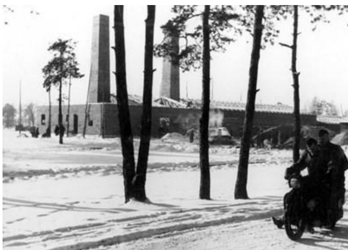
Inverno 1942/1943, lavori di costruzione del crematorio IV.
